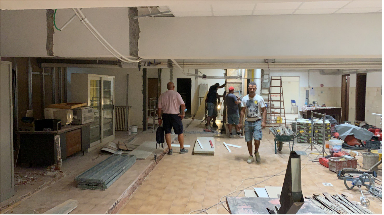
Figura 2 : Cantiere di Via Gibelli
